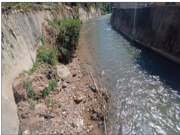
FOTOGRAFIA N°02: Tramo del Río Huallaga con socavación severa en la margen izquierda, evidenciando un derrumbe o deslizamiento de material hacia el cauce, reduciendo su sección y generando riesgo.
